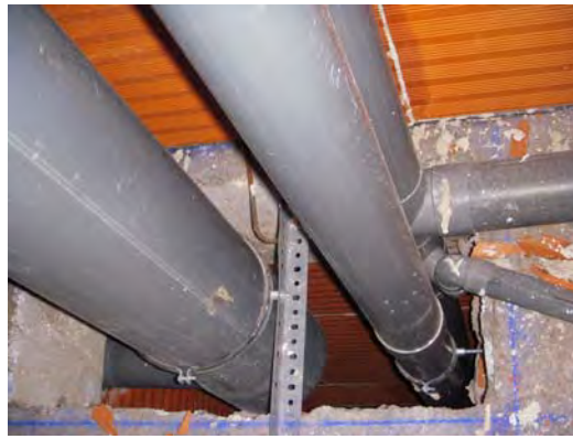
Figura CP-11. Ejemplo de anclaje de conductos de ventilación y de bajantes
