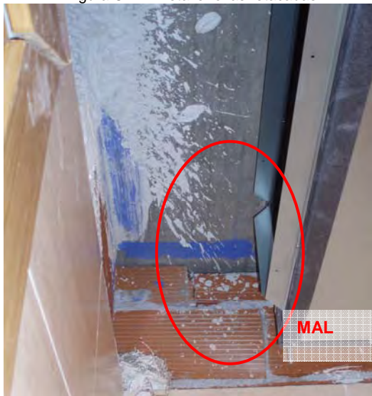
Figura CH-2. Detalle encuentro forjado partición
