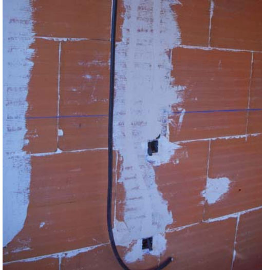
Figura CH-1. Detalle rozas retacadas
