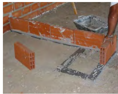
Detalle del replanteo y ejecución de particiones con bandas elásticas
