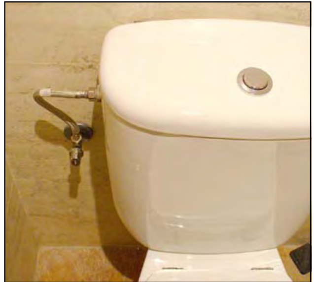
Figura CH-5. Conectores flexibles y junta elástica desolidarizadora
