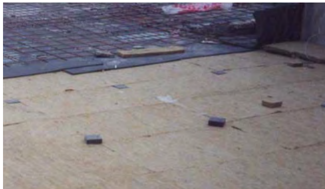
Figura R_INST-02. Ejemplo de un suelo flotante
