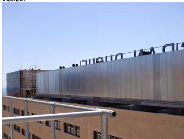
Figura 04. Detalle de la instalación de pantalla
