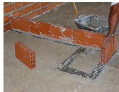
Detalle del replanteo y ejecución de particiones con bandas
