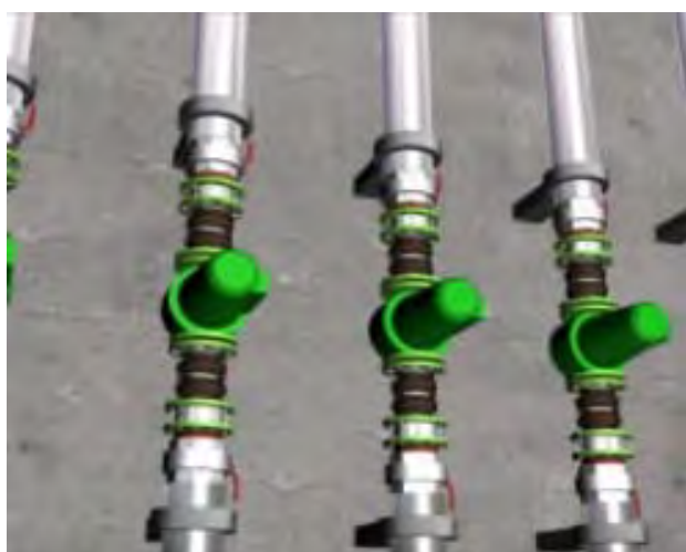
Figura CAL-04. Ejemplo bombas de impulsión con maguitos elásticos
