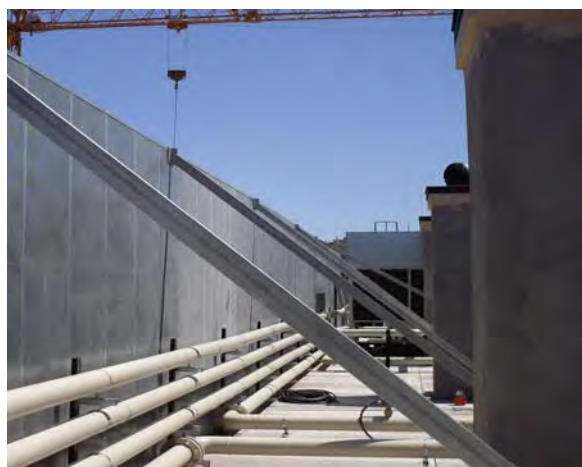
Figura 03. Colocación de tirantes para la sujeción de de pantallas
