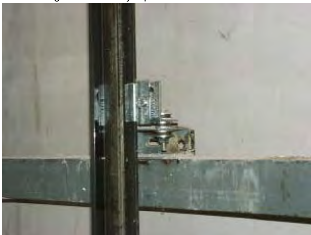
Figura ASC-04. ejemplo de anclaje de guías
