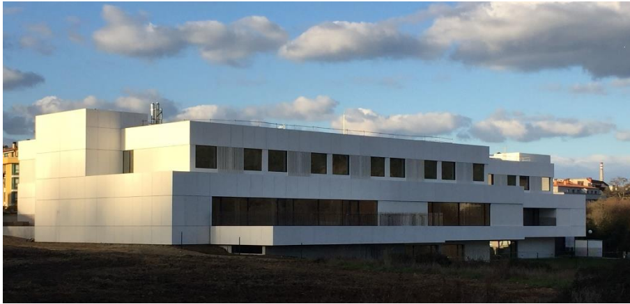
Figura.- Fundación Amancio Ortega. 4.500 m 2 de panel cáscara de GRC en blanco liso y texturizado con anclajes de aluminio para fachada ventilada
