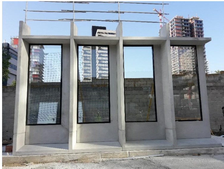
Figura.- Carpintería y acristalamiento de ventanas incorporado directamente en el panel en obra, antes de su montaje
