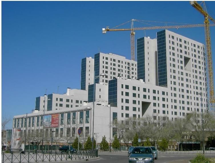
Figura.- Edificio de viviendas en Coslada (Madrid). El principal interés de este edificio consiste en haber alcanzado veinte plantas sobre rasante y cuatro más de sótano con el sistema constructivo de paneles prefabricados de hormigón portantes
