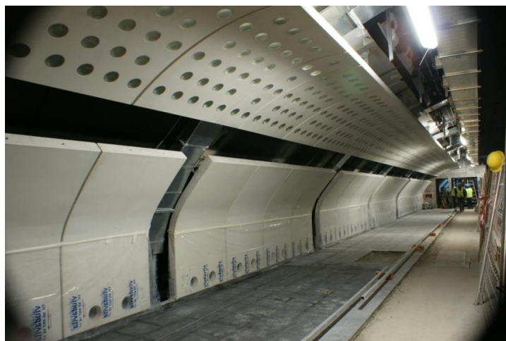
Figura.- Revestimiento interior línea de metro en Barcelona (España)
