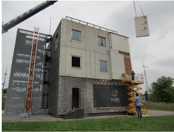
Figura.- Colocación de paneles del proyecto "ETIXc" para el desarrollo de un sistema de aislamiento térmico prefabricado para envolventes de edificación con acción descontaminante y autolimpiante. Edificio Kubik de TECNALIA
