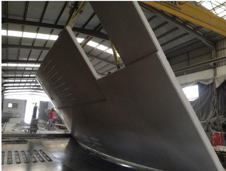
Figura.- Volteo de panel en fábrica, una vez ha alcanzado una resistencia mínima para poder ser manipulado
