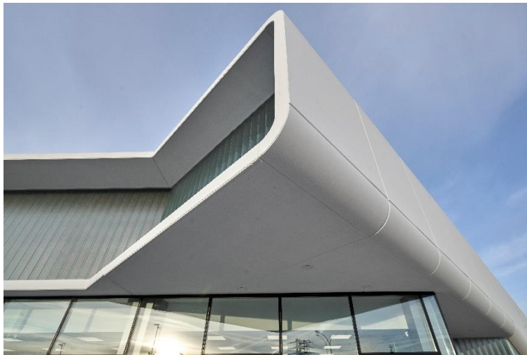
Figura.- Edificio prefabricado a base de pilares alta resistencia HA-70, vigas de cubierta doble T y forjado de placa alveolar con voladizos de 4 metros, que se completan con una fachada de hormigón arquitectónico mediante paneles curvos y texturizados
