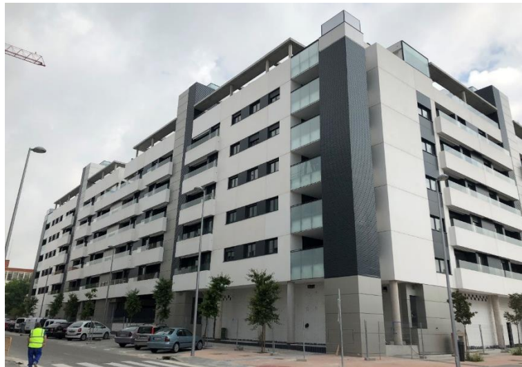
Figura.- Imagen de las fachadas del edificio recién finalizada su ejecución
