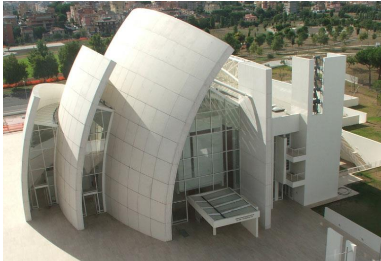
Figura.- Iglesia Dives in Misericordia (Roma), primera obra de gran envergadura que se dotó de la tecnología descontaminante en paneles de hormigón
