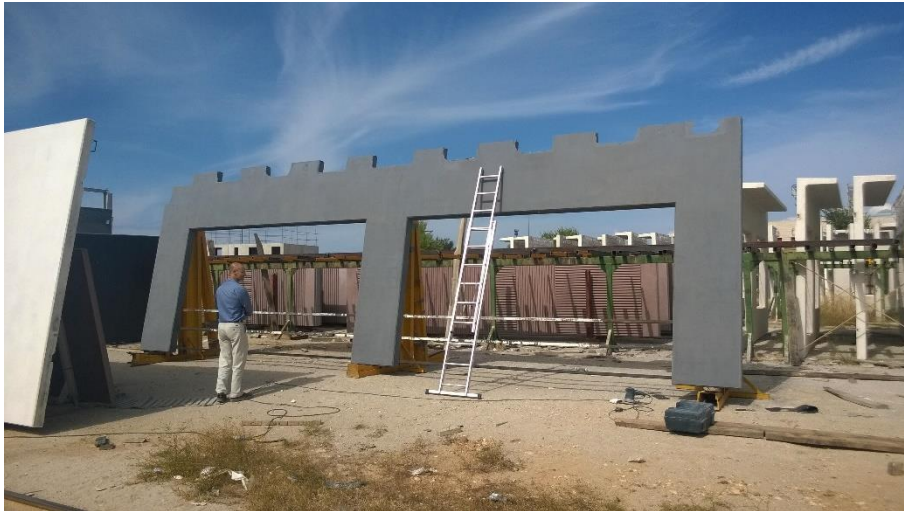
Figura.- Panel con los huecos de ventanas ya preparados de fábrica
